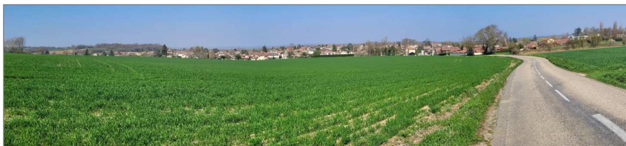
Axe de grand développement en direction de l'entrée Sud du bourg d'Anthon depuis la montée de la Barre
