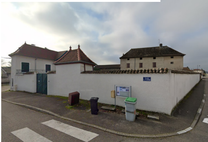
Clos avec une forme bâtie implantée en L
