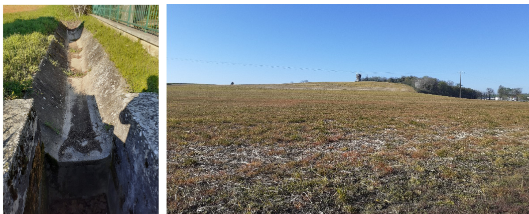
Figure III.2: A gauche, ouvrage de canalisation des eaux de ruissellement derrière la mairie. A droite, vue du Mont Revois d'où peut provenir le ruissellement.
