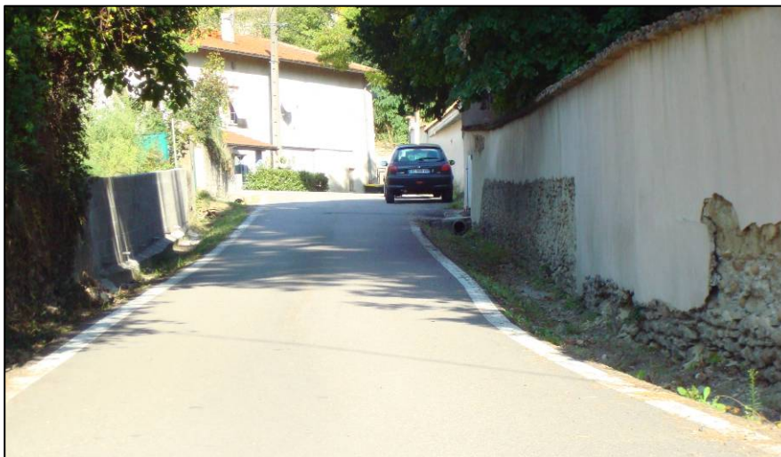
Cloisonnement de la route par des murets
