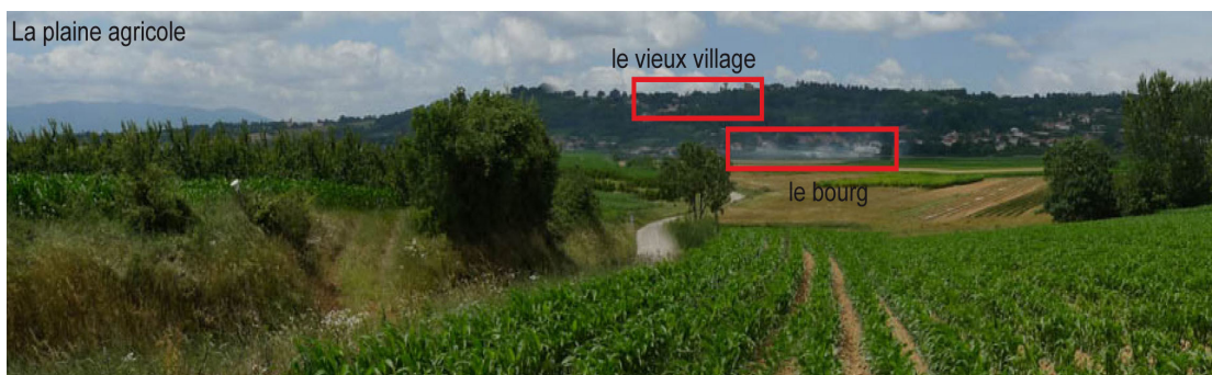
Vue depuis la plaine sur le coteau
