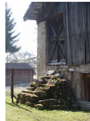
Porte de grange à l'étage
