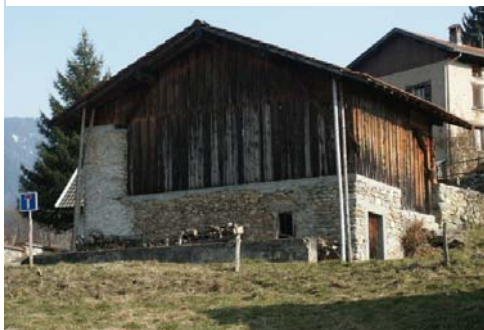
Extension du bâti en bois
