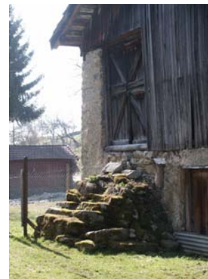
Porte de grange à l'étage
