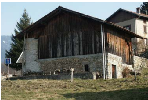
Extension du bâti en bois
