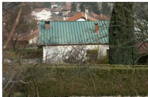
Toiture en bac acier
