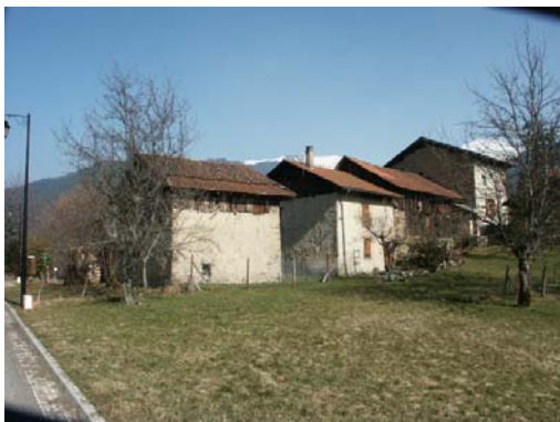
Toiture à 2 pans
