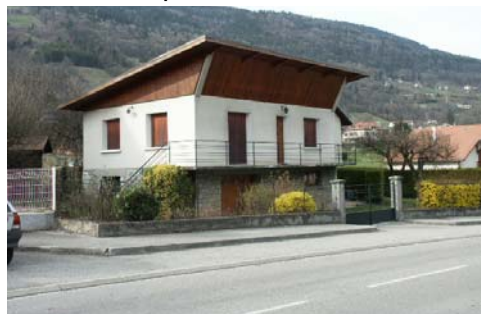
Toiture à 1 pan
