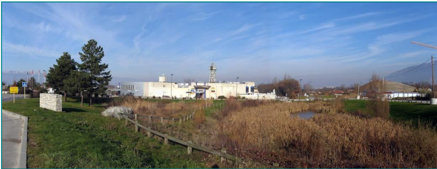
Exemple d'un bassin de retenue d'une zone d'activités à Neydens (74). Les eaux pluviales sont épurées par un filtre à roseaux avant d'être
