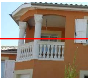
Type de balustres interdits
