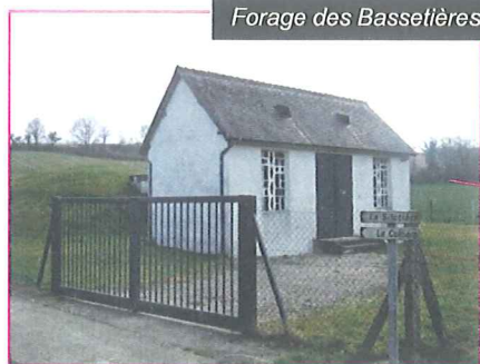
Forage des Bassetières
