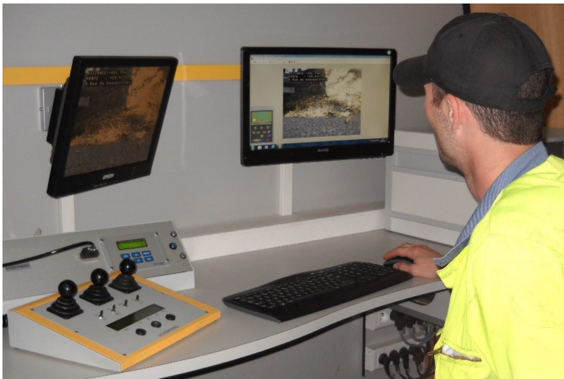
Exemple d'inspection télévisée avec véhicule spécialisé
