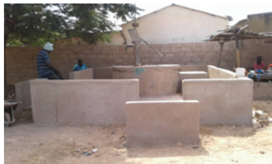
Puits Moustapha Tiam après travaux
