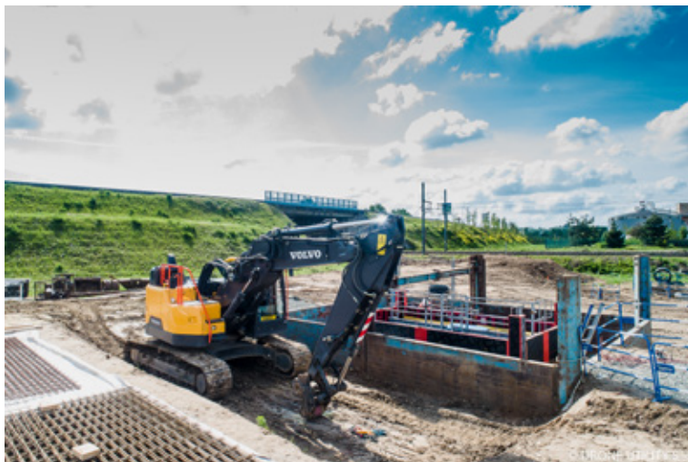
Construction d'un point de métrologie sur collecteur Nord et Centre en amont de la Step de La Riche
