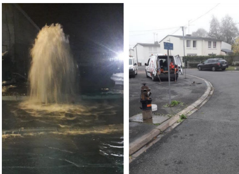
Fuite sur poteau incendie suite à accident de voiture rue Prony le 7 février à Joué-lès-Tours
