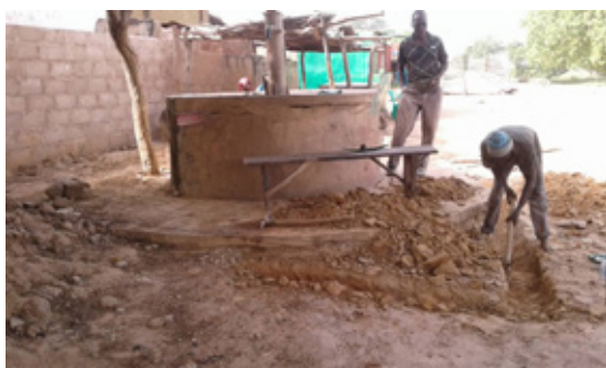
Puits Moustapha Tiam avant travaux
