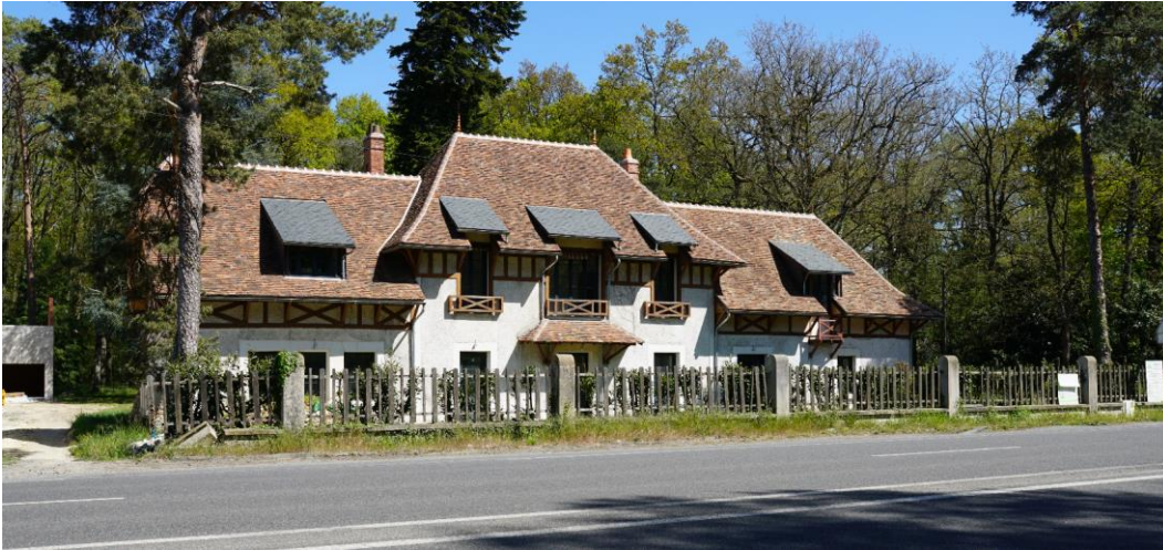
1 - Vue de la façade principale de la construction existante depuis la D910.
