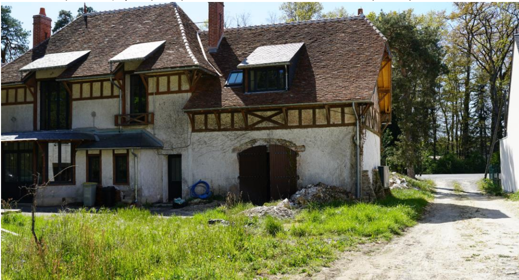
3 - Vue de la façade arrière de la construction existante depuis la parcelle.
