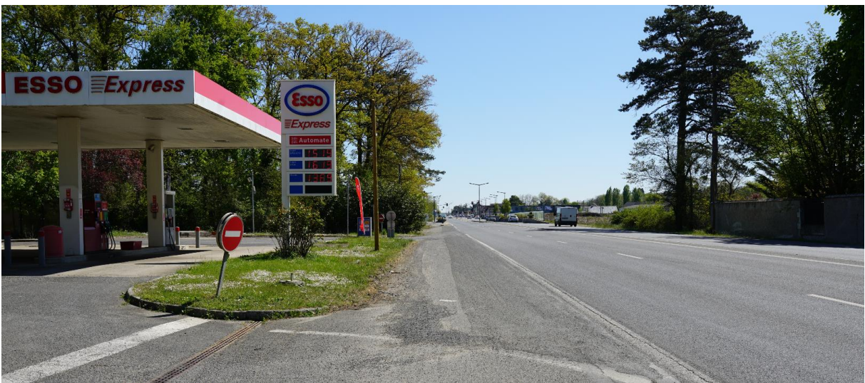
2 - Station Esso en fonctionnement le long de la D910 et limitrophe de la parcelle AD 1077.
