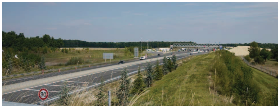
Le péage de Veigné sur l'autoroute A85 (Ecopertica, 2013)
