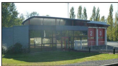
Centre de secours du Balzac
