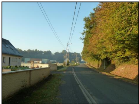
Rue de la Baronne, en direction de Saint-Epain : des trottoirs peu adaptés aux Personnes à Mobilité Réduite
