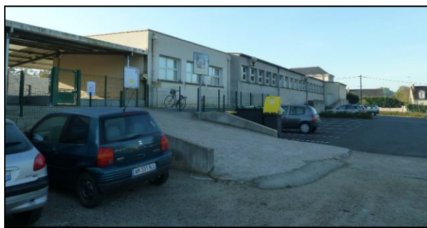
Accès à l'école élémentaire par le parking de l'école
