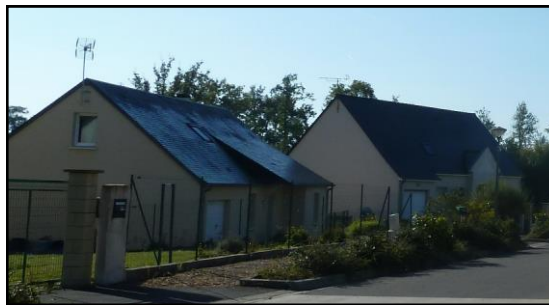
Pavillon - lotissement du Clos Saint-Michel
