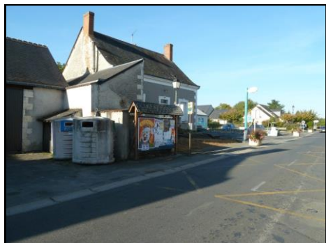
Rue Honoré de Balzac : des obstacles sur les trottoirs (lampadaires, bacs à fleurs) ne permettant pas la circulation des Personnes à Mobilité Réduite
