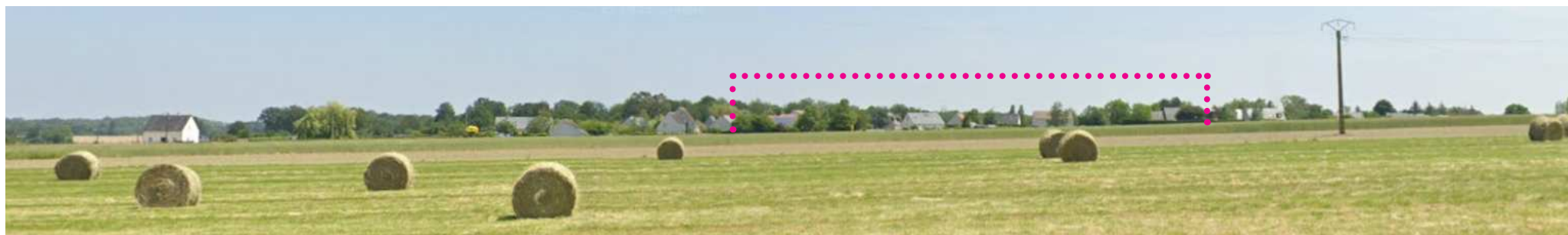
Vue de la route départementale 48
