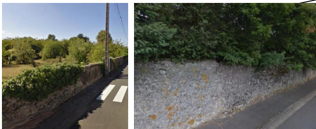
Des murs d'enceinte en pierre
