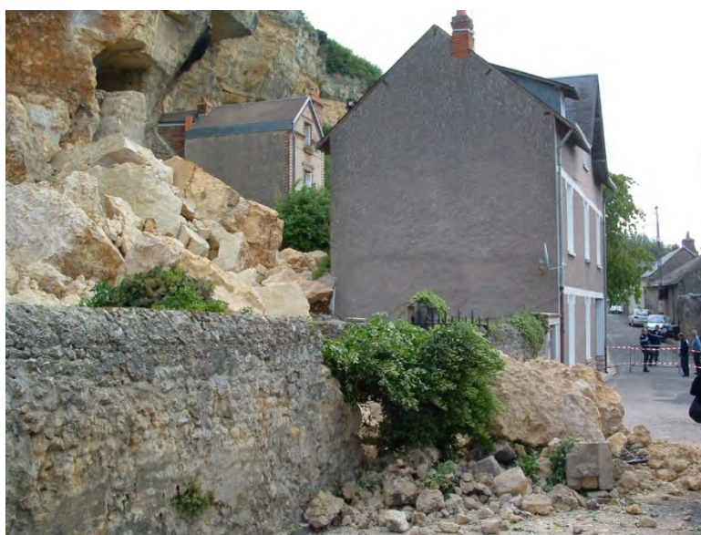
30 avril 2010, écoulement rocheux, coteau de la Lanterne, rue des Basses Rivières
