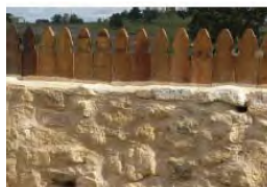
Muret avec gîtes intégrés
