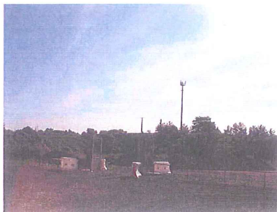
2 - Entrée du site, bordé de talus boisé, actuellement dépôt de matériaux
