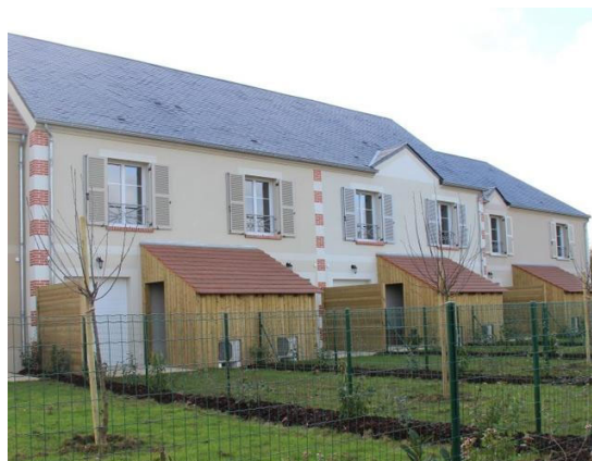
Après : une opération de logement
