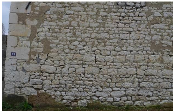
Appareillage de maçonnerie pleine de Tuffeau. Angles des murs extérieurs en pierre de Tuffeau sciée.
