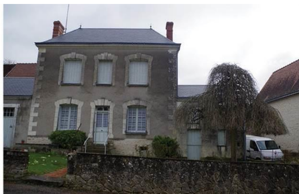
2 - Maison de notable : Façade ordonnée et plan rectangulaire. En recul de la voie, elle est au centre d'un jardin/cour. Les baies plus hautes que larges.
