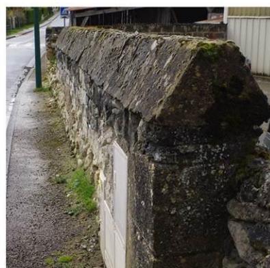
Muret de maçonnerie de pierre calcaire. Chaperon en pierre de taille pleine masse.
