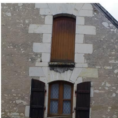
Encadrement de baies en pierre de taille de Tuffeau, calcaire à grain fin. Murs enduits de mortier à base de chaux.
