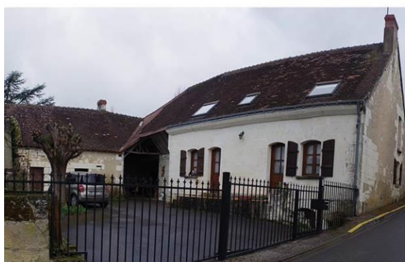
5 - Ferme en «L» en coeur villageois : Volumétrie simple R+C. Pignon sur rue faisant une orientation idéale de la cour au Sud. Encadrement des baies en pierre de taille de tuffeau (calcaire à grain fin). Maçonnerie principale en pierre de tuffeau non sciée joint mortier. Tuile plate rectangulaire rouge brun.
