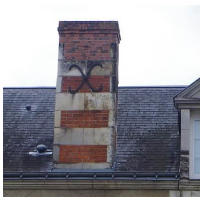
Cheminée de maçonnerie mixte de briques et de pierres de taille de Tuffeau. Couverture de toit en ardoise (moins répandue que la tuile rouge brun)
