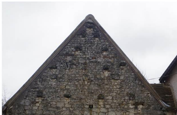
Pignon aveugle en maçonnerie de pierre de Tuffeau. Pierres disposées en saillie pour goutte d'eau.
