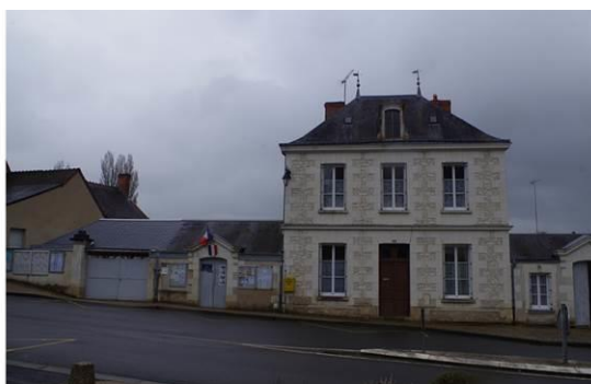
Ancienne mairie, actuelle école : Bâtiment point focal depuis le Sud du village. Façade équilibrée et ordonnée. Maçonnerie de pierre de Tuffeau. Couverture en ardoise.
