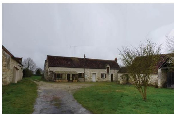
6 - Ferme en «U» de l'habitat dispersé : Elle présente deux granges latérales et une habitation délimitant une cour ouverte. Le bâti ancien R+C est non jointif. Encadrements de pierre de taille de tuffeau, maçonnerie intérieure de pierre non taillée, couverture en tuile plate brune. Porche remarquable.
