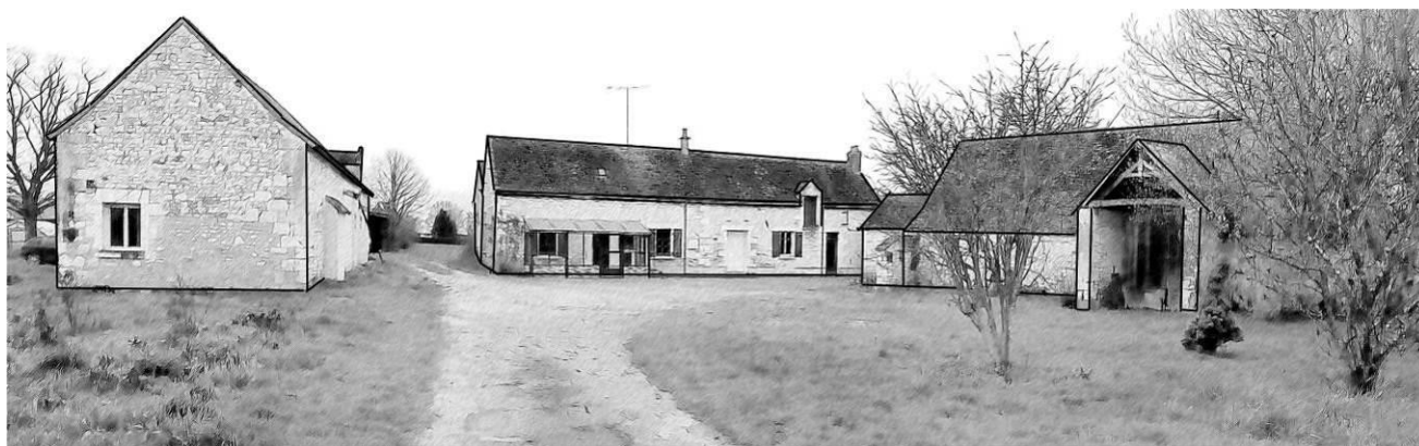
Ferme ouverte en « U » avec 2 granges et une unité d'habitation (Source photo : Environnement Conseil, Mouzay au lieu-dit « La Bordinière »)
