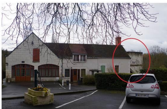
Pigeonnier de l'ancien château : Unique témoignage du château des Voyer d'Argenson démoli en 1808. Le toit poivrière du pigeonnier circulaire a été démoli en 1970. Les murs circulaires encore présents datent de 1671.
