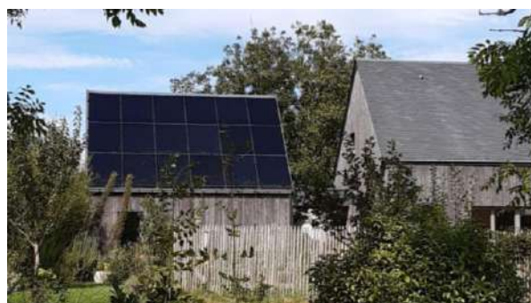
Panneaux formant la couverture complète d'une annexe, en Bretagne. La taille de la construction a été adaptée en fonction des dimensions des modules.
