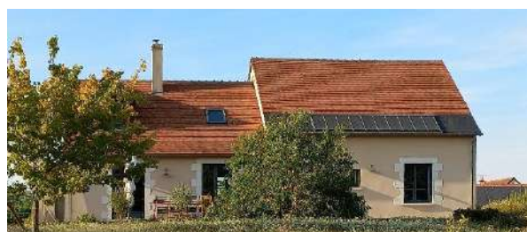
Petits panneaux formant une bande étroite en bas de toiture en ardoise à Rochecorbon (37).
