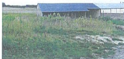
Hangar (partie ouverte) à démolir
