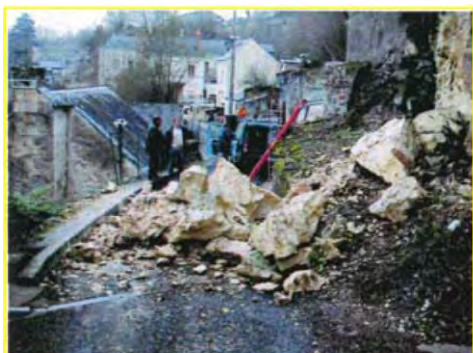
Eboulement à Mortvouses (janvier 2004)
