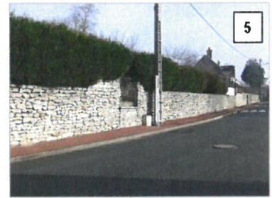
Un accès impossible, en raison d'un fort dénivelé
