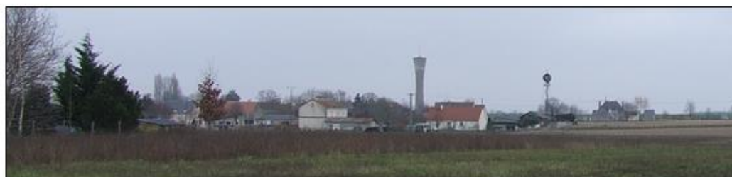
Vue, de gauche à droite, sur la peupleraie, le château d'eau et l'éolienne depuis la rue de la Promenade
