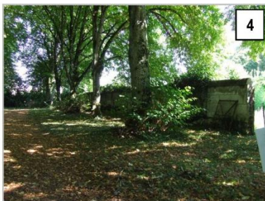
Vue depuis le parc sur le mur au nord du site de l'Épinay
