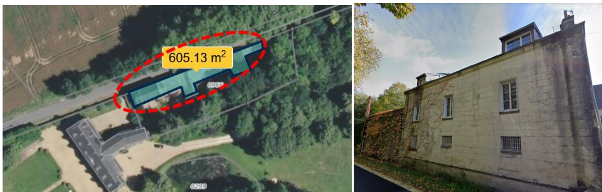
Photo 6. Localisation, dimensionnement et photographie des bâtiments ajoutés aux changements de destination au Château de l'Épinay
