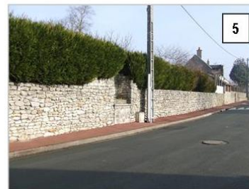
Un accès impossible, en raison d'un fort dénivelé
