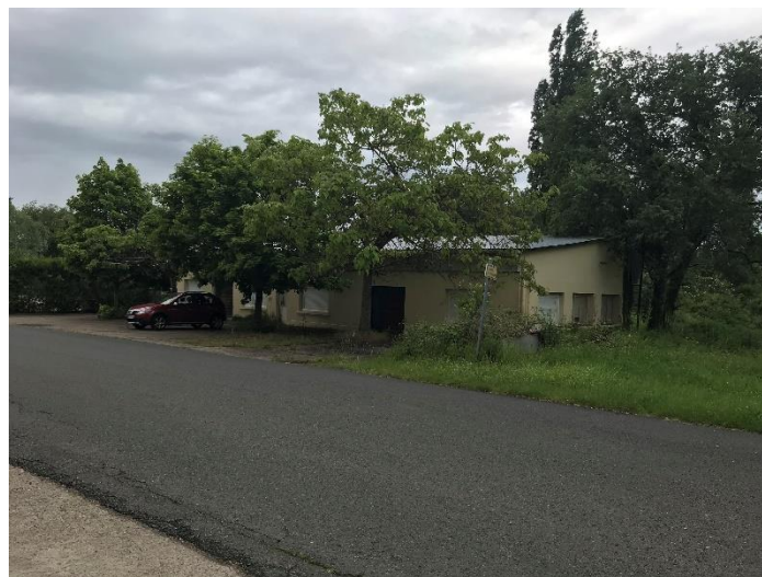
Locaux communaux face au site de l'ancienne MEAC faisant l'objet d'un projet de réhabilitation
