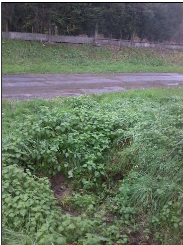
Photo de la buse dans fossé avant l'exutoire
