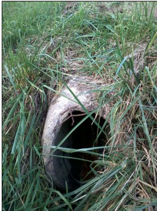
Photo de la buse en tête de fossé
