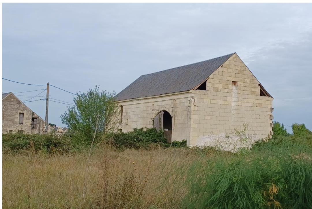
Photographie du bâtiment
