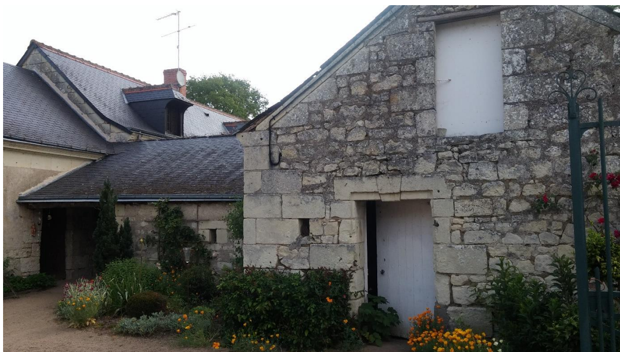
Photographie du bâtiment
