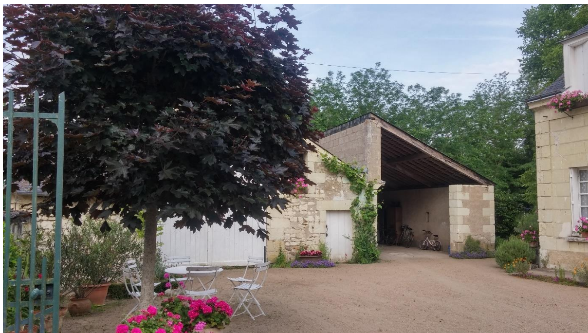
Photographie du bâtiment
