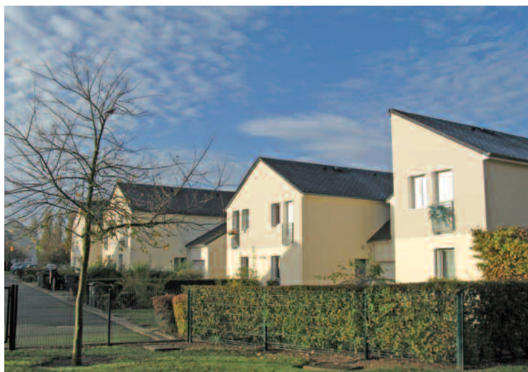
Maison, rue des Mûriers
