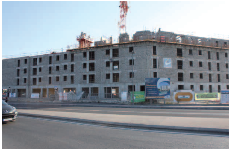
Le nouveau quartier de la Porte des Arts en construction Photo : Ville de Chambray-lès-Tours
