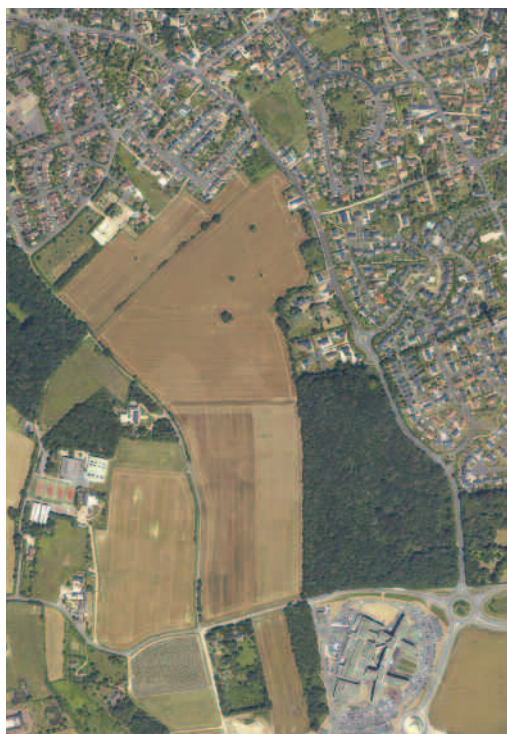
Vue aérienne du site de l'éco-quartier de la Guignardière
