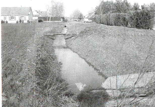
Emissaire au niveau de la station d'épuration et du lotissement des Ormes
