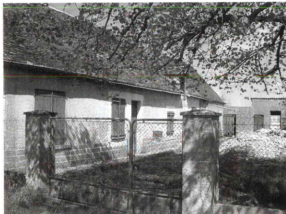
Exemple de bâti à restaurer [les Petits Terrageaux]
