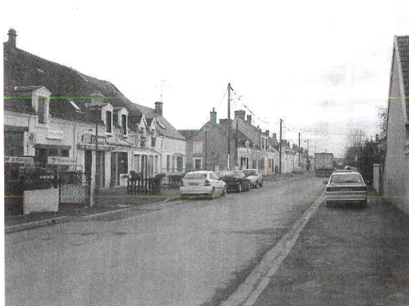
Développement urbain linéaire et alignement sur rue [rue de la Gare]
