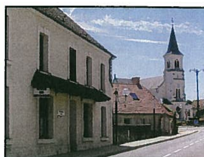
la Maison des associations et le Centre de loisirs
