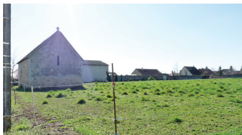
Réalisation : 6t 2017; Prise de vue depuis la Rue Saint-Jacques
