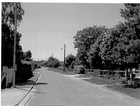
Développement urbain lâche le long de la rue de la Promenade
