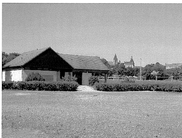
Le complexe sportif, près de l'étang des Buissons
