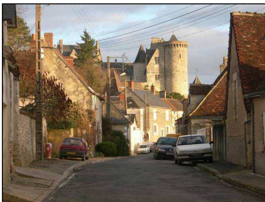
Vue sur le château depuis la rue Haute
