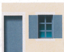
Porte, fenêtre et volets identiques.
