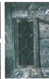
Au XIX e siècle, on y ajoute une imposte vitrée en partie haute pour augmenter l'éclairage, la porte restant toujours pleine pour assurer son rôle protecteur.
