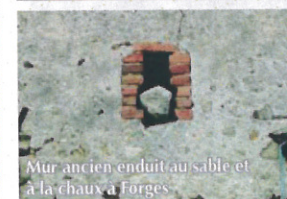
Grison, grès ocre, grès rouge recouverts d'un enduit ancien à la chaux et au sable de rivière
