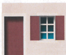
Porte et volets identiques, fenêtre de la même couleur que les encadrements en calcaire.
