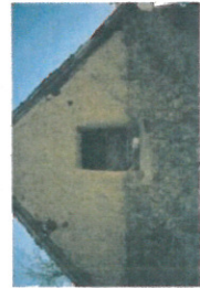
Les ouvertures sont inscrites dans des cadres bois ou, pour les plus petites ouvertures des bâtiments annexes, directement taillées dans la bauge.
