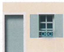
Menuiseries et ferronnerie identiques.
