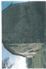
A Prissac, la structure des maisons du bourg est soulignée par des chaînages de grès ocre.
