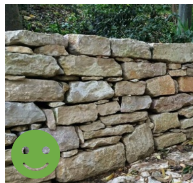
Les murs en pierres sèches apportent des refuges de biodiversité
