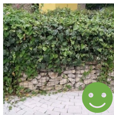
Les murs en gabions végétalisés peuvent aussi très bien s'insérer dans le paysage
