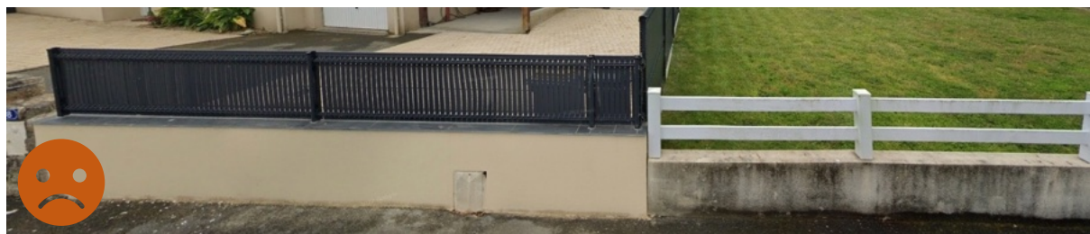
Problème d'harmonie entre clôtures voisines
