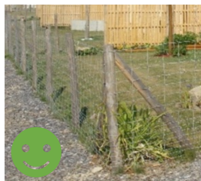
Le grillage à mouton à grande maille est plus discret et il permet le passage de la faune
