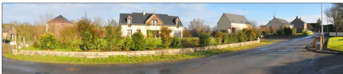
Figure 8 : Nouvelles constructions de la zone UE, rue de Rennes
