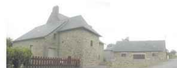
7 : Ce type d'architecture peut-être considéré comme légitime par rapport à la typologie architecturale du village des Bas Chemins. Mais son emplacement sur la ligne de rupture de pente (maison de droite sur l'image n°8) remet en cause toute la structure paysagère locale. Il faut limiter les implantations nouvelles sur ces emplacements géographiques.
