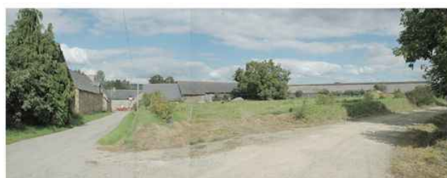
6 : Le bâtiment agricole récent, à droite de la photographie s'intègre relativement bien dans la trame du village. Le talus, en premier plan, ne laisse apparaître que la toiture qui semble suivre la continuité des autres bâtiments.
