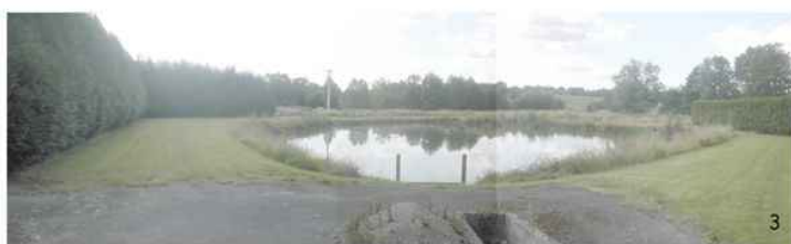
Bassins de lagunage
