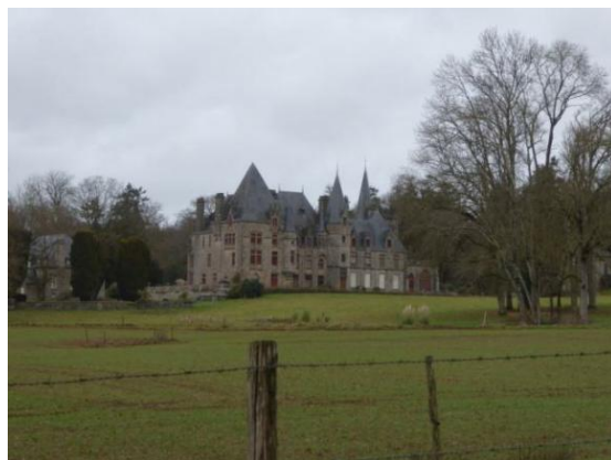
Figure 11 : Prise de vue du Château du Bois-Cornillé à Val-d'Izé
