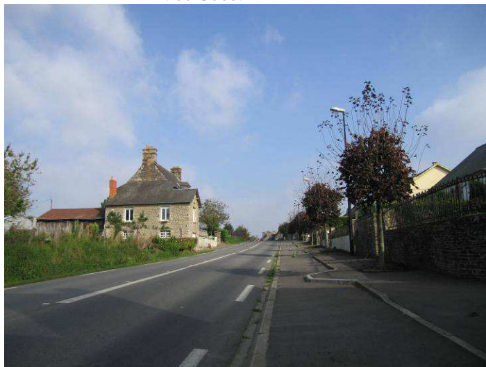
Aménagements réalisés entrée Ouest
