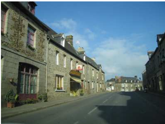
Front bâti rue de Ville Cartier – traitement uniforme
