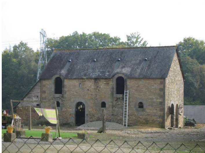
Bâtiment en cours de rénovation au sein d'une exploitation agricole
