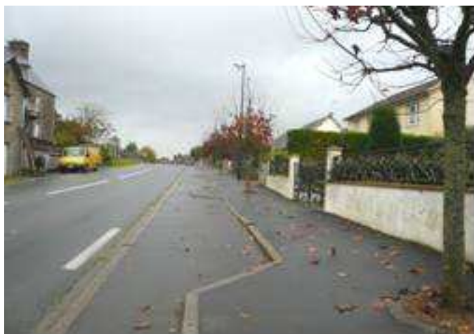
Cheminements piétons intégrés dans l'aménagement d'entrée de bourg
