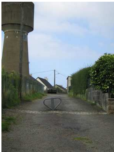
Liaison entre le bourg ancien et les nouveaux quartiers
