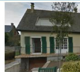
Maison des années 50 avec escalier extérieur et balcon en acier
