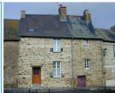
Maisons à étages des XVII - XVIIIème siècles avec encadrements des ouvertures avec linteau
