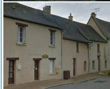
Ensemble de maisons remaniées du XVIIème siècle, place Saint Médard
