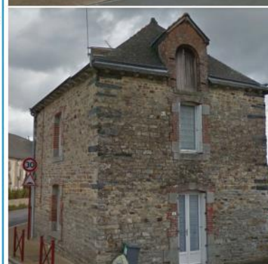
Maison de bourg avec lucarne passante en brique et chaînage d'angles
