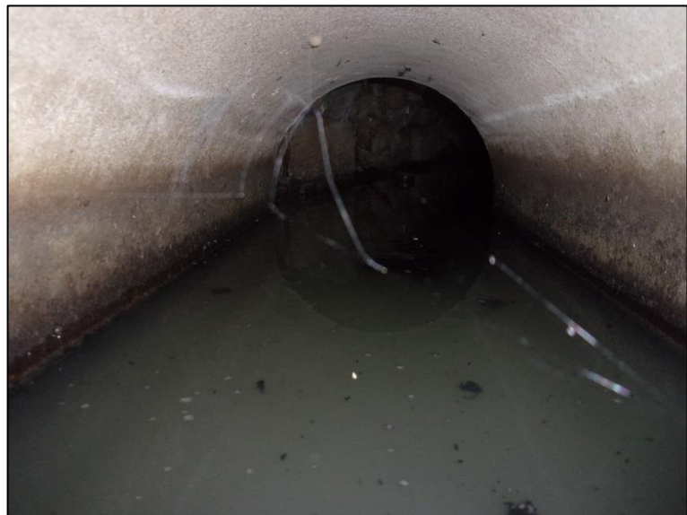
Photo 3 : Vue d'un réseau à curer – Réseau Ø400 de la traversée de la RD777 « les Quatre Chemins »
