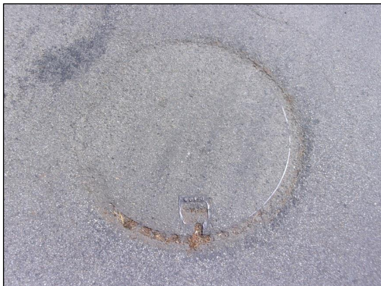
Photo 4 : Vue d'un tampon non accessible
