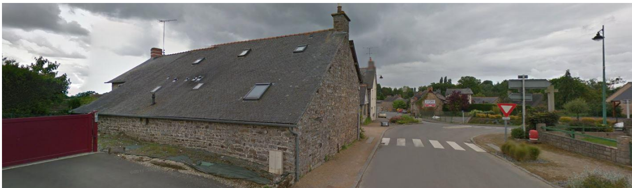
Porte urbaine : vue sur les premiers bâtiments anciens
