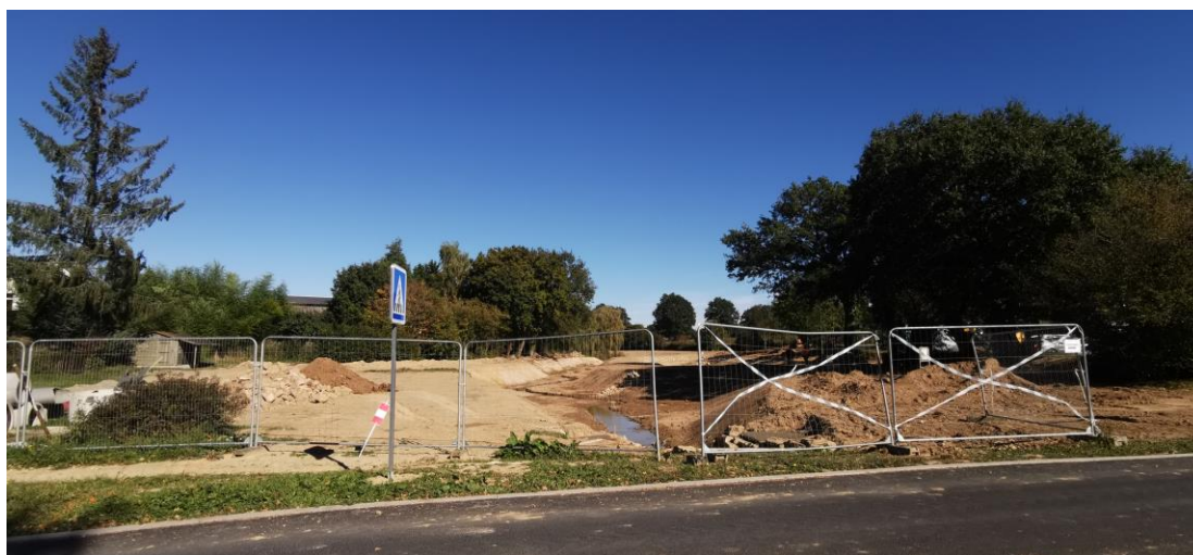
Travaux de renaturation du ruisseau de la Vallée octobre 2023
