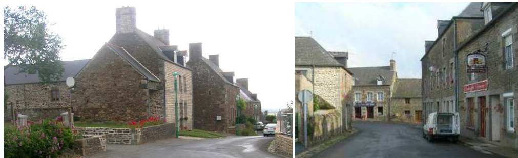
Le bâti du bourg
