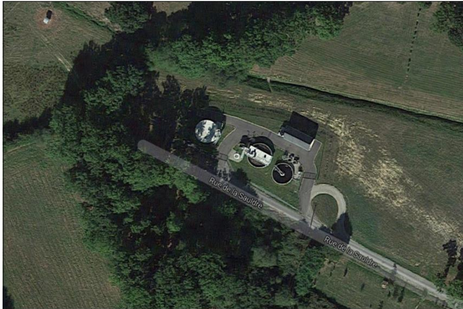
Figure 12 : Station d'épuration de Sixt-sur-Aff (Google map)
