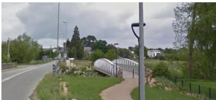
PHOTOGRAPHIE D'AMENAGEMENT DE VOIRIE ENTRE LA GARE ET LE CENTRE-VILLE
