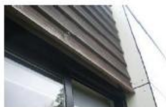
Pipistrelle (espace mur / bardage bois)
