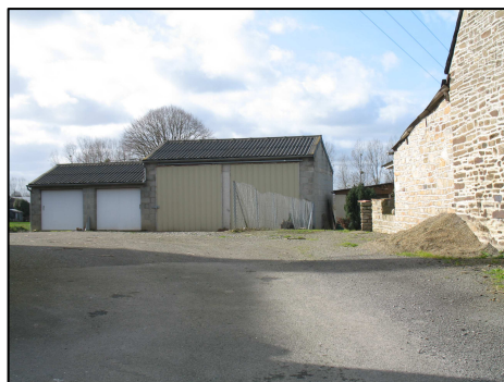
Accès au bâtiment des services techniques
