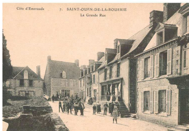
La typologie R+1+C des habitations implantées en front de voie est caractéristique du centre ancien.
