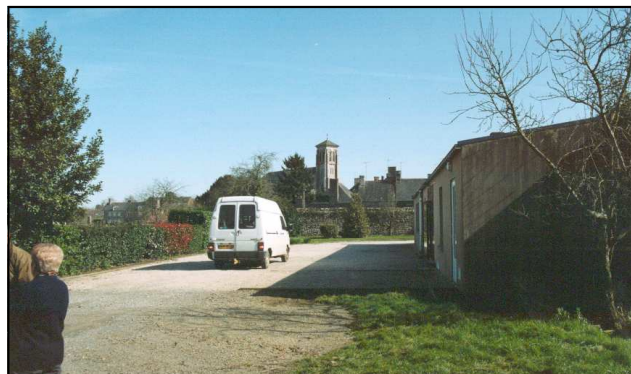
L'arrière de la salle polyvalente et la cantine (Avant travaux)
