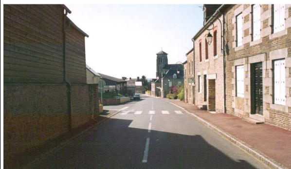
La RD 15 au cœur du bourg: les aménagements de la voie correspondent aux usages en place.
