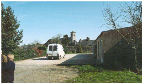
L'arrière de la salle polyvalente et la cantine (avant travaux)
