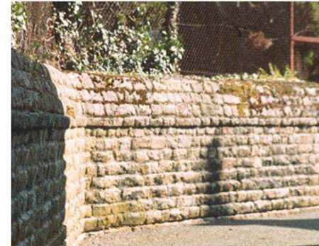
Murs en moellons de schiste granit
