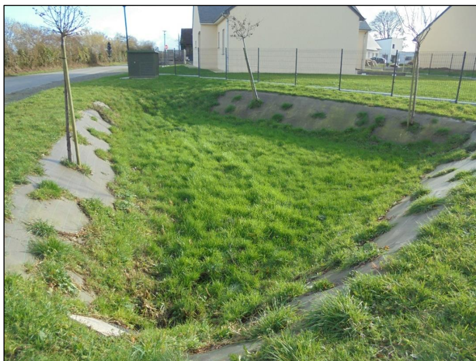
Photo 1 : Vue du bassin d'orage de la Résidence Plein Sud
