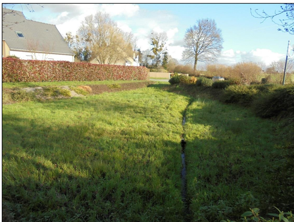
Photo 2 : Vue du bassin d'orage de la Résidence Plein Sud
