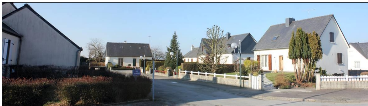
Maisons pavillonnaires rue des Caméllias : exemple de maisons sur demi sous-sol et mouvement de terrain associé.
