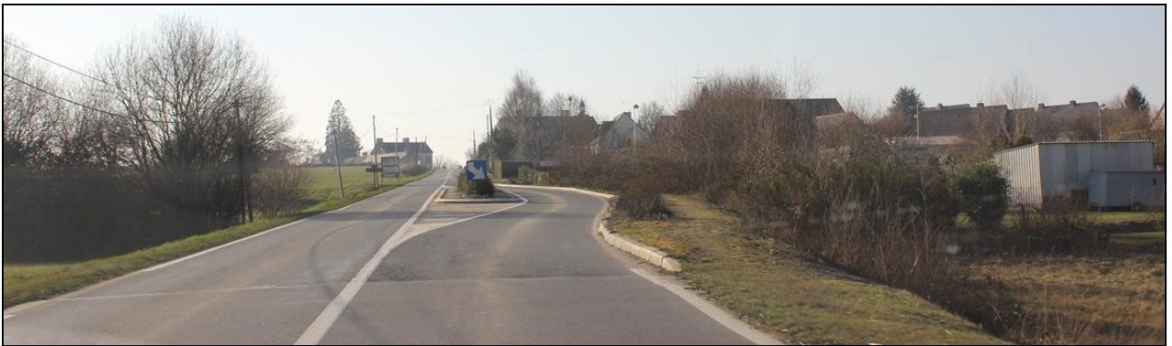
L'aménagement routier amorce l'entrée vers le bourg.
