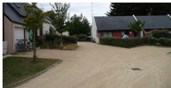
Desserte d'un lotissement composée de matériau perméable.
