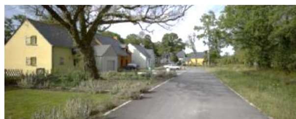
Voie mixte en revêtement perméable
