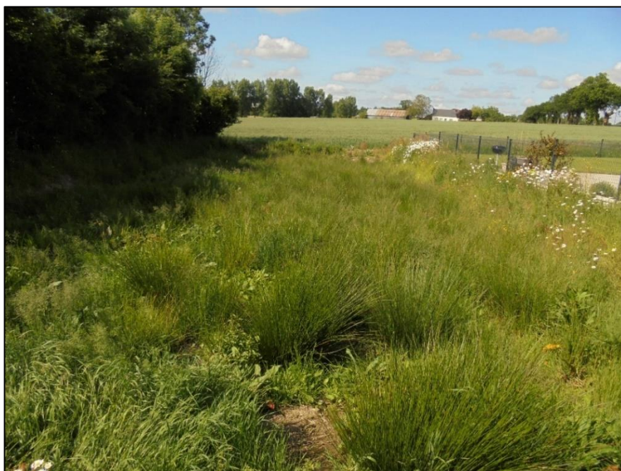
Photo 3 : Vue du bassin d'orage provisoire de la ZAC Villa Maria
