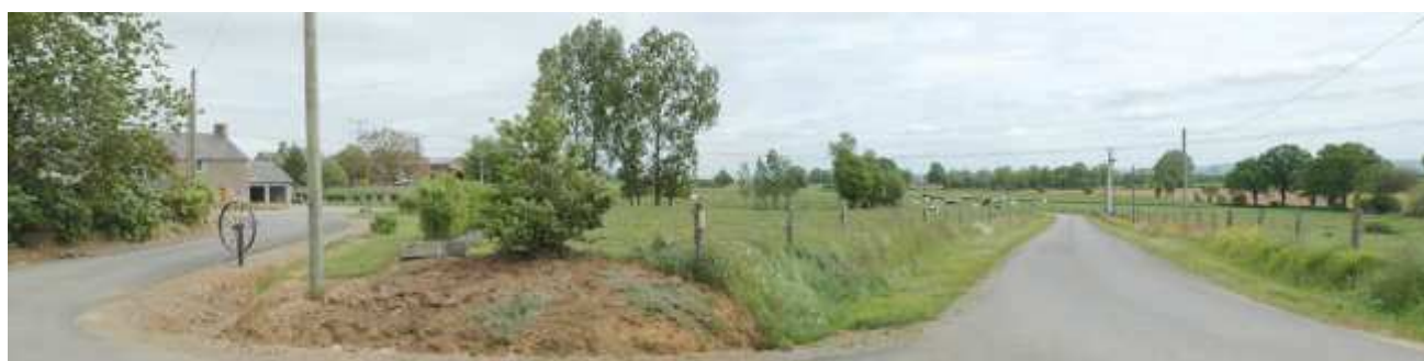
Façades en agglos et bâtiments d'exploitation à la Jardièrre
