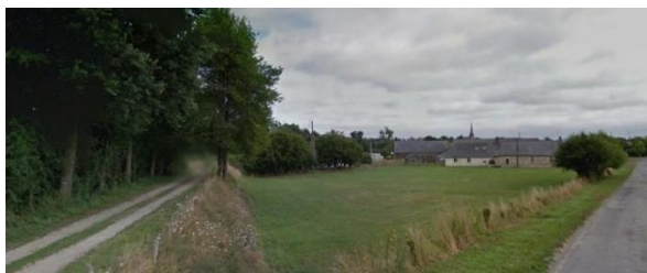
Ancienne ligne SNCF à la Chaussée
